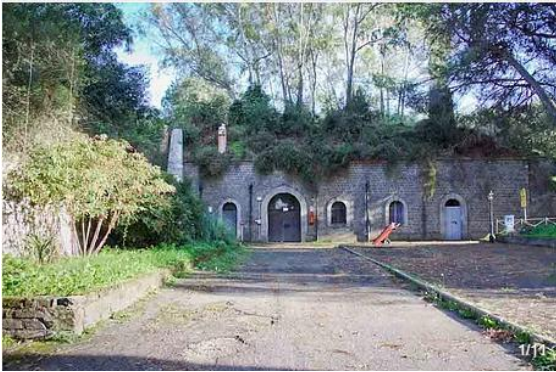
Entrata Batteria Acquasanta
