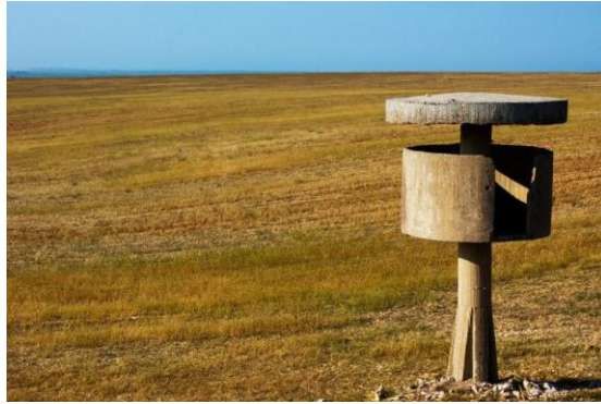
Altamura – località Ceraso, una delle sei altane di vigilanza della ex base missilistica
